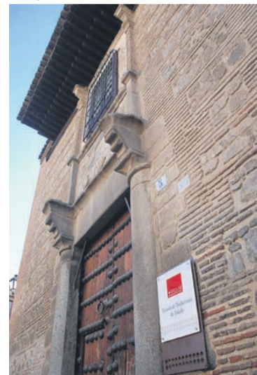
Fachada de la Escuela de Traductores
